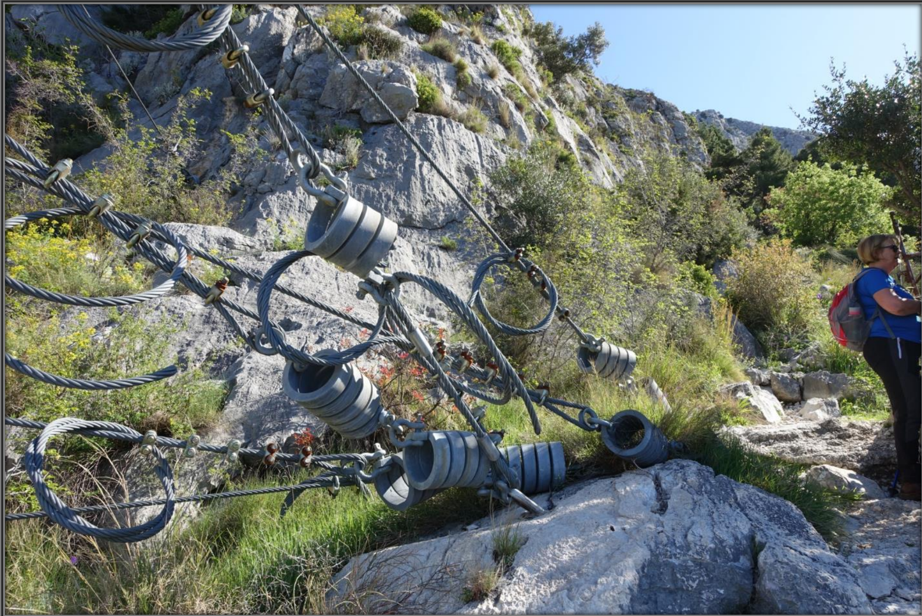
Jeklenice so z vzmetmi sidrane v skale
