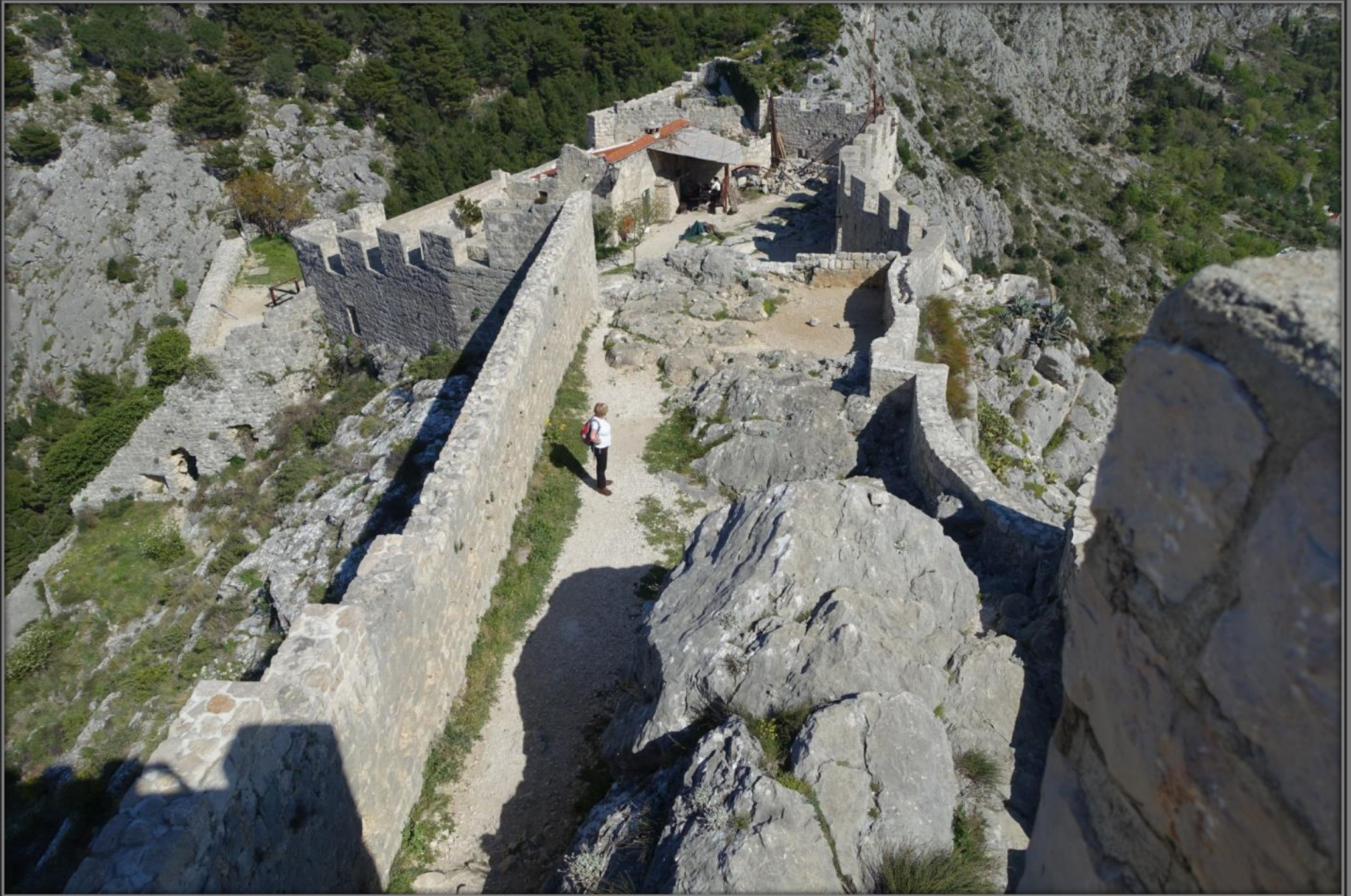
Fortica je zanimivo zgrajena
